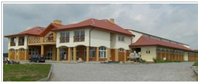
Przykładowy obiekt do odbioru
